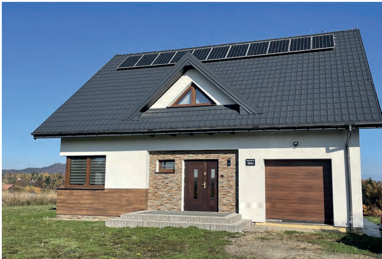
Rysunek 32. Dachowa instalacja PV u prosumenta indywidualnego (istniejąca).
