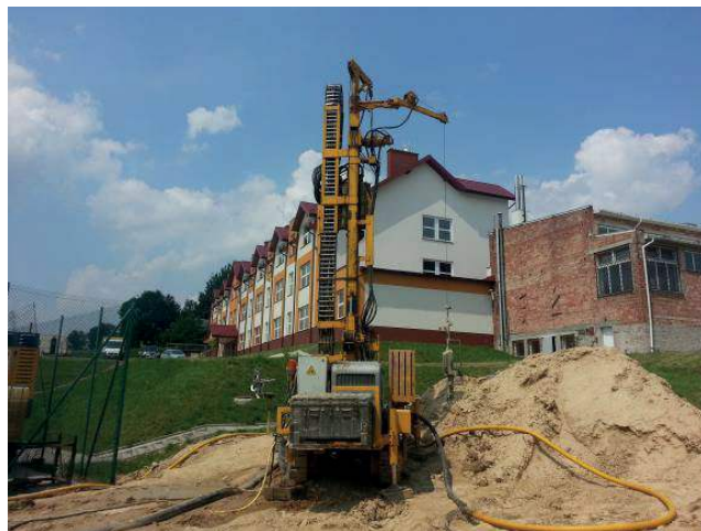
Rys. 3A. Montaż pompy ciepła w Zespole Szkół Podstawowych w Pałecznicy województwo małopolskie
