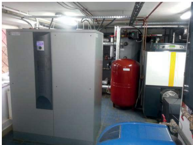
Rys. 3A. Montaż pompy ciepła w Zespole Szkół Podstawowych w Pałecznicy województwo małopolskie
