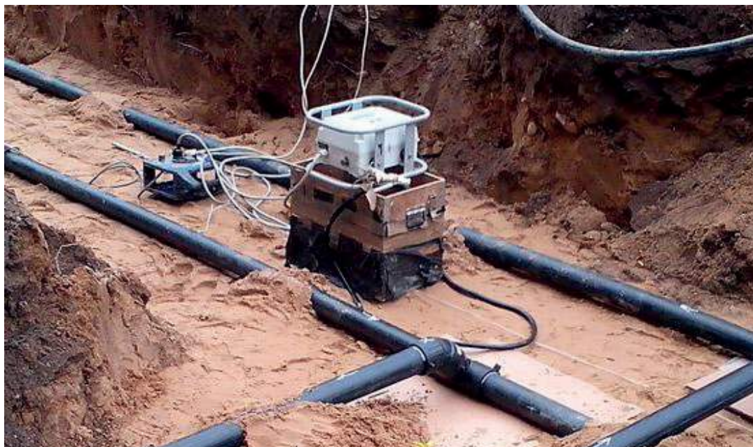
Fot 2. Instalacja pomp ciepła pod terenem placu zabaw
