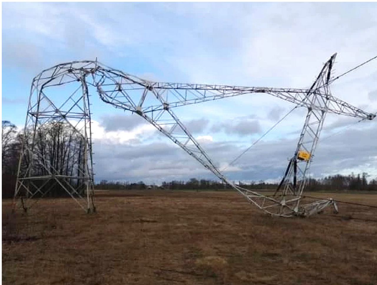
Rysunek 1. Szkody w sieciach elektroenergetycznych Orkanu Eunice (21 lutego 2022).
